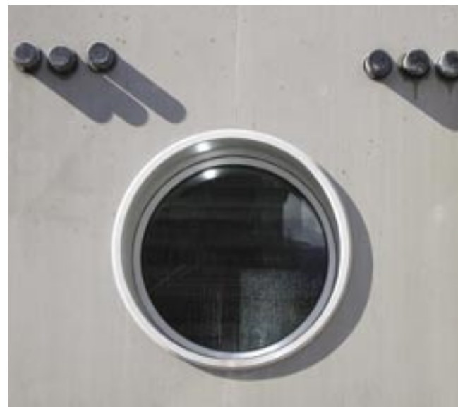
Erdbebenertüchtigung von bestehenden Bauten im Inland: Mit Stahlstützen sanierter Hörsaal der ETH Zürich (oben) und die mit neuen, gut armierten Betontragwänden ausgestattete Polizeizentrale in Sitten VS.
