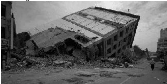
1. Umgekipptes mehrstöckiges Gebäude in Taiwan, September 1999
