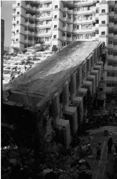
2. Umgekipptes mehrstöckiges Gebäude in Taiwan, September 1999
