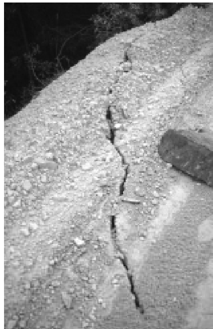
Bild 3: Bodenriss in Schotterstrasse
